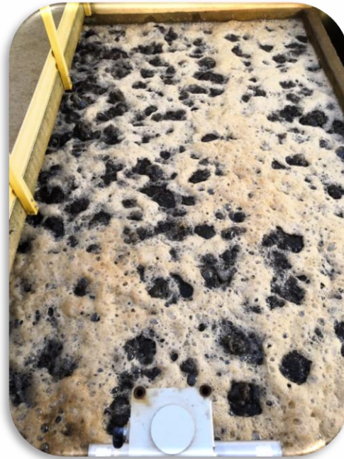
Opération de lavage d'un filtre FILTRALITE
