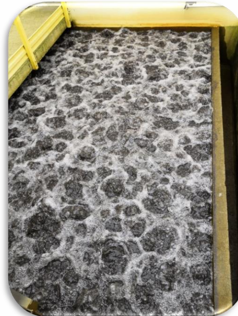
Opération de lavage d'un filtre FILTRALITE
