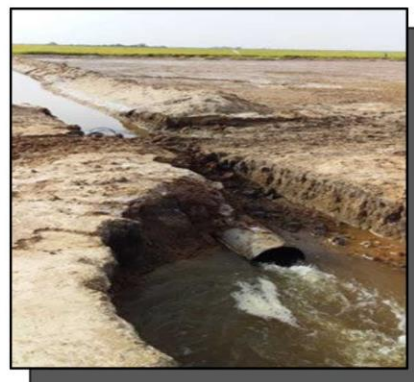
Image 1: Canal de drainage de Débi-Tiguet
